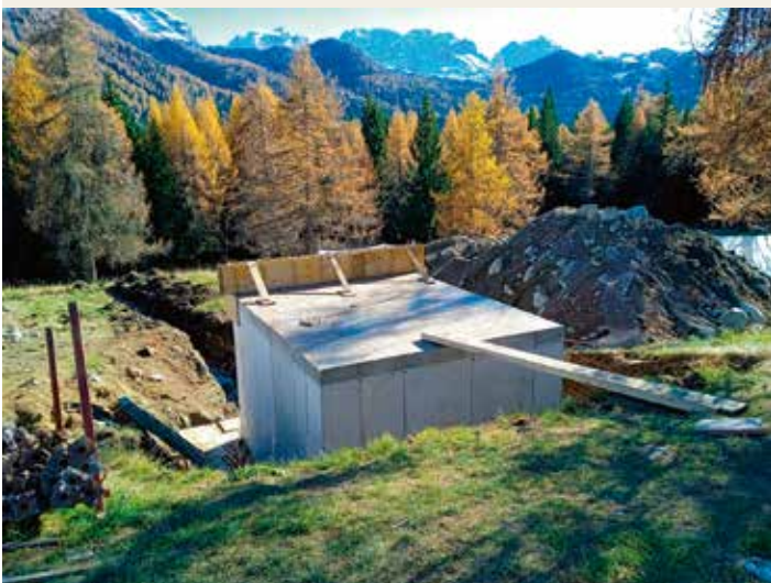
La cabina SET in costruzione a Malga Darè
