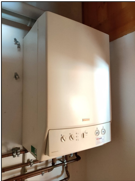
Foto 2-3 – A sinistra: generatore di calore per il servizio di climatizzazione invernale e produzione acqua calda sanitaria (marca IMMERGAS mod. ZEUS MAJOR). A destra: collettore dell'impianto di riscaldamento
