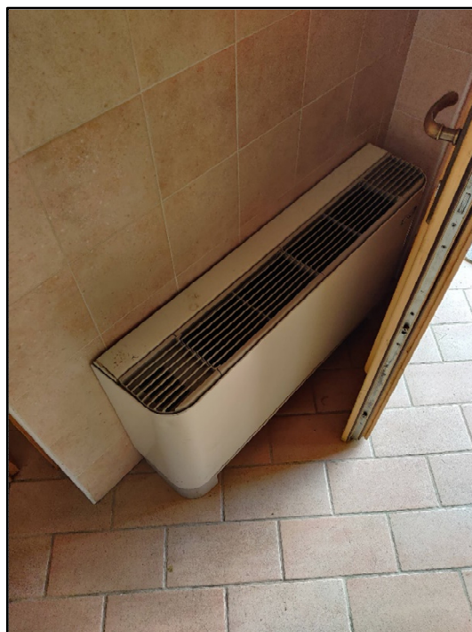
Foto 5-6 – A destra: particolare del serramento. A destra: ventilconvettore nella zona spogliatoio
